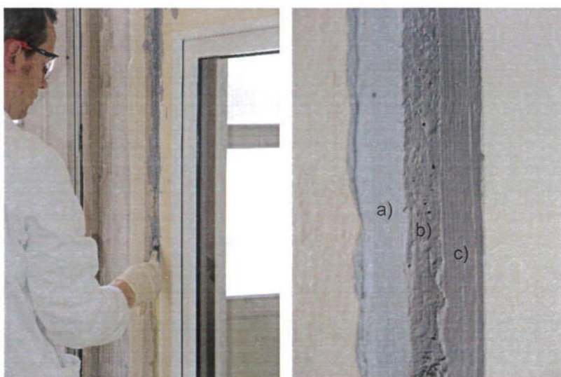
Abb. 1 (links): Streichen der Wetterschutzpaste ClearoPAG 169 mit einem Pinsel Abb. 2 (rechts): Äußerer Anschluss Wetterschutzpaste ClearoPAG 169, a) am Beton, b) am Volumenklebstoff (vereinzelt sind Löcher sichtbar), c) am Fensterrahmen
