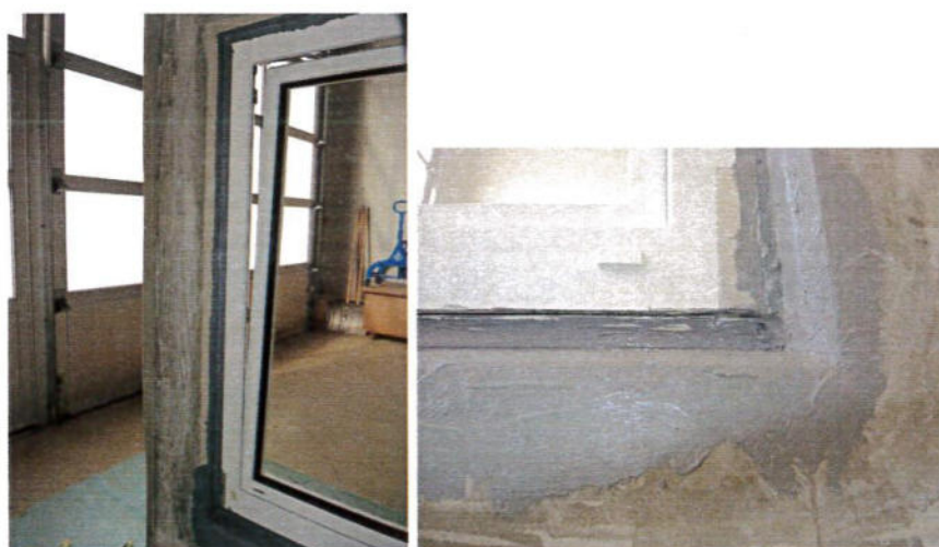
Abb. 3 (links): Fetiggestellter äußerer Anschluss mit Wetterschutzpaste ClearoPAG 169 Abb. 4 (rechts): Unten fetiggestellter äußerer Anschluss mit Wetterschutzpaste ClearoPAG 169 mit abgedichtetem Gewerkeloch
